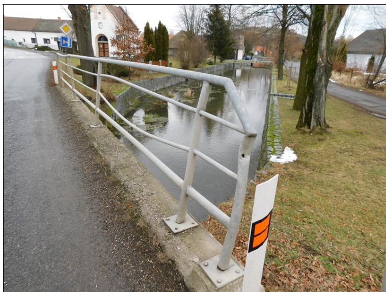
Nárazem poškozené zábradlí na levé římse
