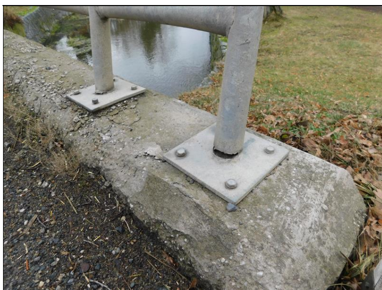
Detail utržených sloupků od patních desek a vytržené kotevní šrouby
