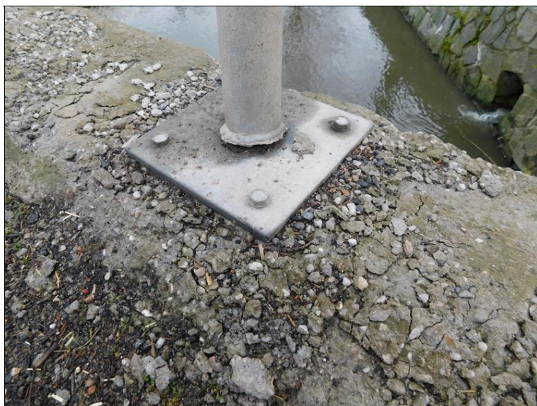
Levá římsa a nárazem poškozený zábradelní sloupek
